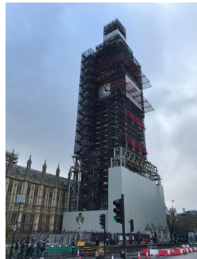
改修工事中のビッグベン
